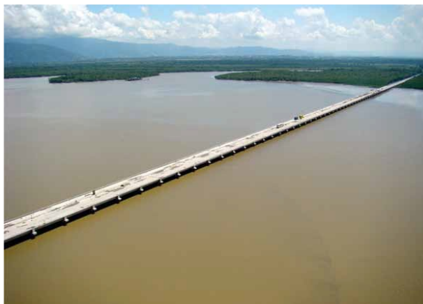
Figura 7 - Porto da TKCSA na Baía de Sepetiba. (RJ).
