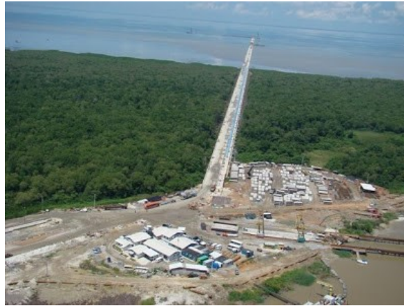
Figura 6 - Área desmatada para construção da siderúrgica e porto, Santa Cruz, Rio de Janeiro (RJ).
