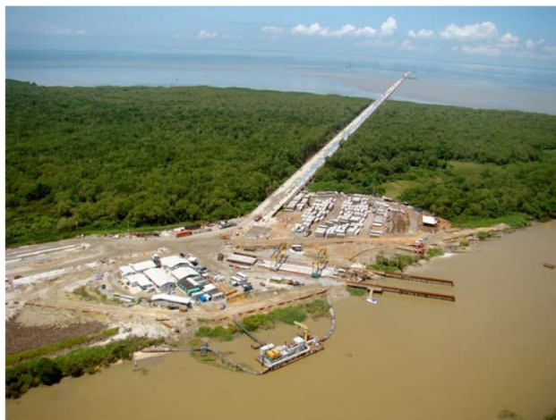
Foto 1: Construção do Complexo Siderúrgico da TKCSA.
