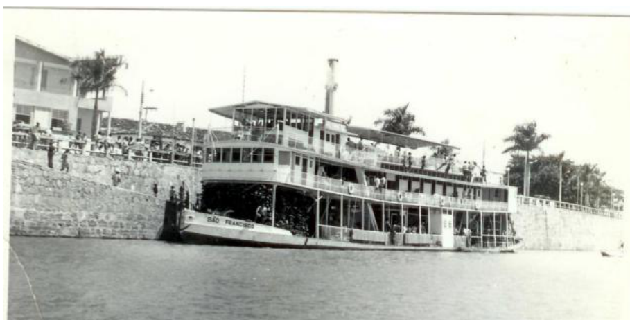
Figura 4: Antigo Vapor do São Francisco
